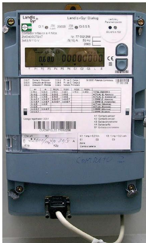
Figura 1.28. Contador eléctrico.
