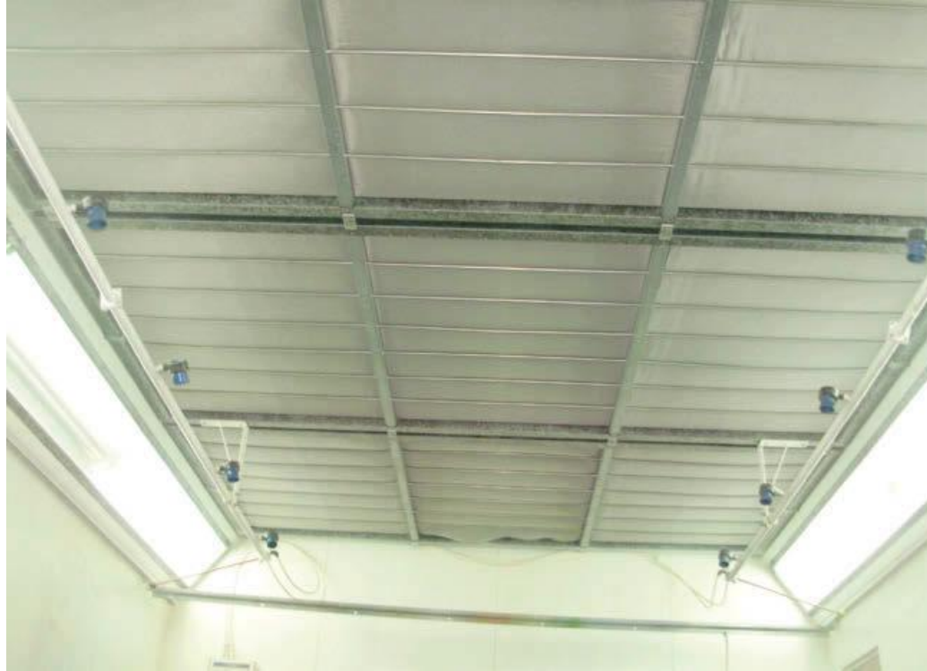
Figura 1.8. Filtro superior ( plenum ).
