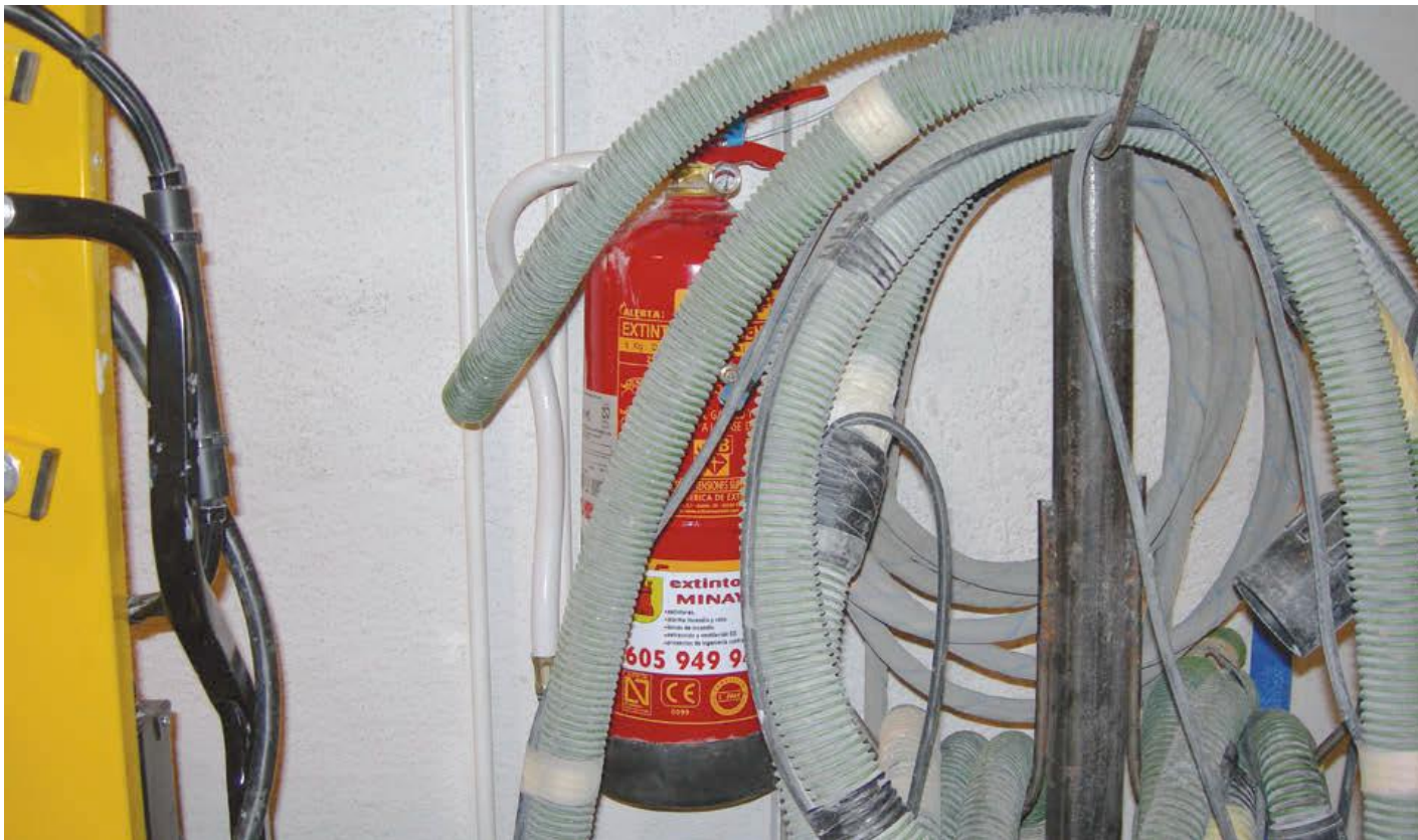
Figura 1.74. Extintores obstaculizados.
