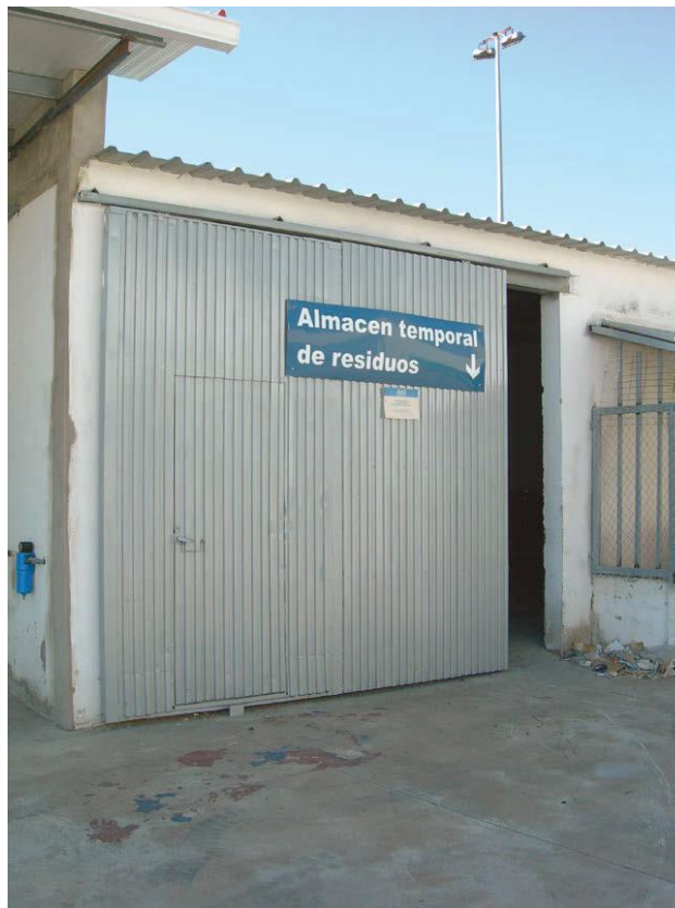
Figura 1.68. Almacén temporal de residuos.
