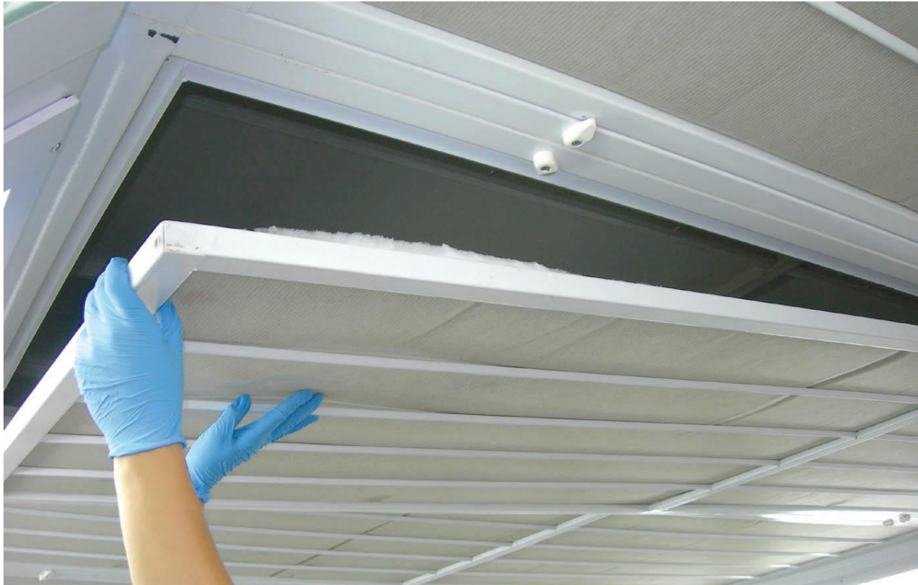
Figura 1.16. Desmontaje del filtro del plenum .
